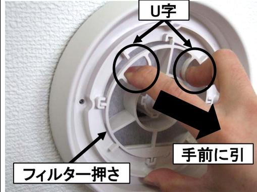
③ フィルターを取り外し、新しいフィルターに交換します。
