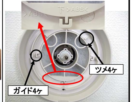
⑤ キャップを取り付ける為、キャップの溝とシャフトのピンの向きを合わせます。
