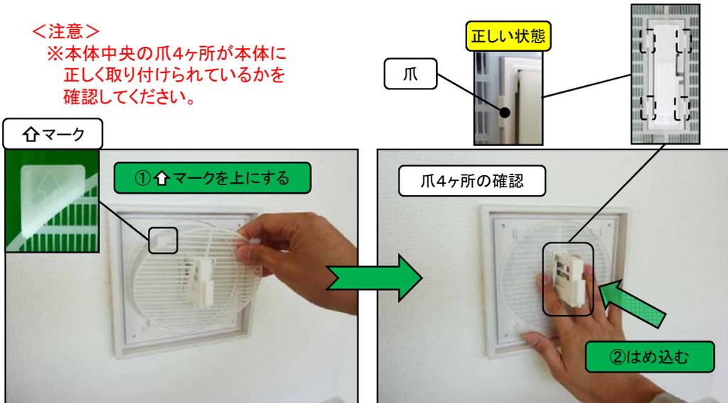
⑥ 作動部先端にパネル取付部を当て、パネルを下へ引き下げてパネルを固定します。パネル取り付け後、「PUSH」部を押して開閉を数回繰り返して問題無いようでしたら作業完了です。
